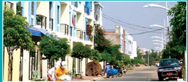
Hệ thống điện chiếu sáng tại các khu đô thị Lighting system in urban areas
