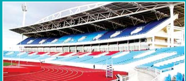
Hệ thống điện chiếu sáng tại các sân vận động Lighting system in stadiums
