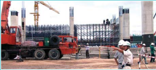
Hệ thống cáp ngầm tại các sân bay Underground cable system in Airports
