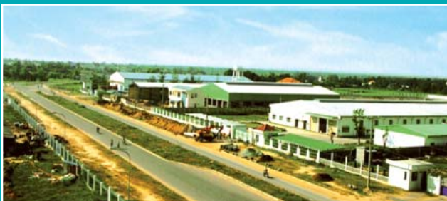
Hệ thống điện chiếu sáng tại các khu công nghiệp Lighting system in Industrial Zones
