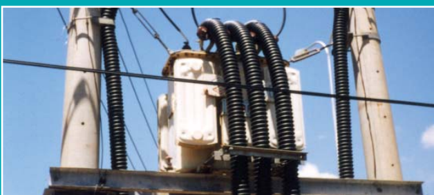
Công trình cáp nổi Overhead installation project
